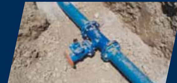
Pose de conduite d'eau potable
