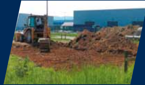
Décapage de terre végétale
