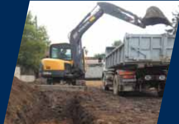
Prolongement des réseaux France Telecom
